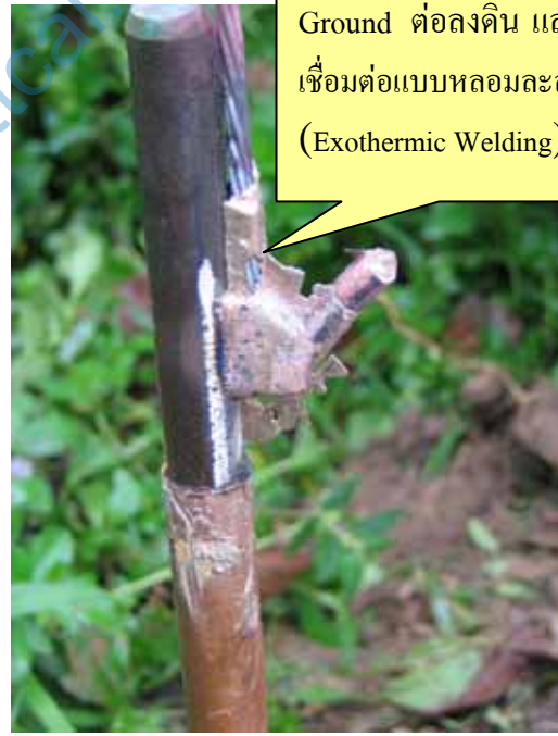
ภาพประกอบที่ 5 แสดงการเชื่อมสาย Ground เข้ากับหลักดิน
