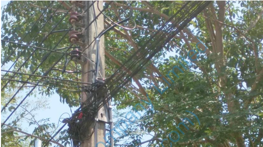
ภาพประกอบที่ 4.16 สาย Armoured Round Type ติดตั้งใช้งานในพื้นที่ที่มีปัญหาสัตว์กัดแทะ
