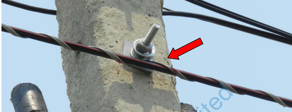
ภาพประกอบที่ 4.9 อุปกรณ์ Thimble Preformed Suspension for Self-Support Cable (ADSS/ARSS) (Tangent ADSS/ARSS)
