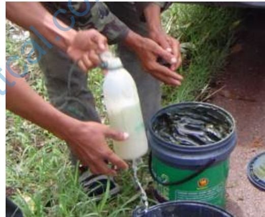
ภาพประกอบที่ 4.2 อุปกรณ์ที่ใช้เคลือบผิวสายเคเบิล OFC ด้วยจาระบีแคลเซียม
