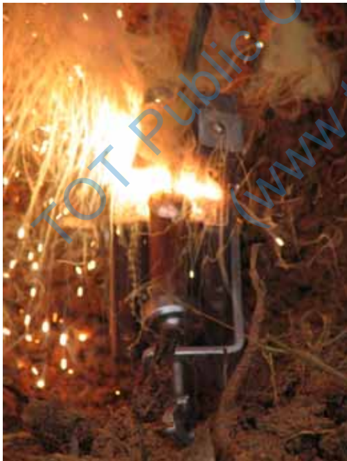
ภาพประกอบที่ 5 แสดงการเชื่อมสาย Ground เข้ากับหลักดิน
