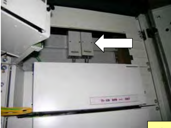
ภาพประกอบที่ 1 ลักษณะหัวต่อออฟติก ของโครงการ TNEP ที่อยู่ ในห้องโทรคมนาคม
