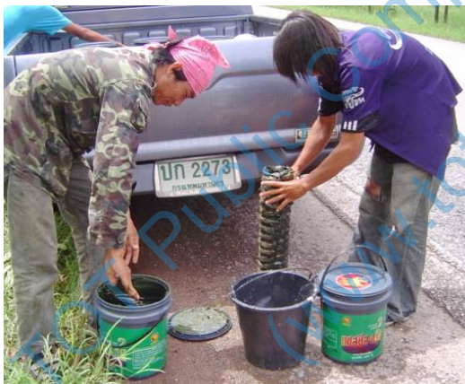
ภาพประกอบที่ 4.2 อุปกรณ์ที่ใช้เคลือบผิวสายเคเบิล OFC ด้วยจาระบีแคลเซียม
