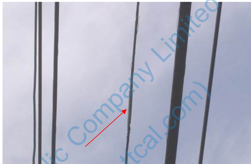
ภาพประกอบที่ 4.4 สายเคเบิล OFC หลังจากทาเคลือบจาระบีแคลเซียมเรียบร้อยแล้ว
