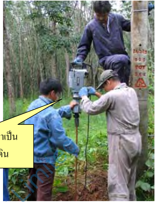
ภาพประกอบที่ 4 แสดงการใช้ก้อนไฟฟ้าที่ใช้ตอกหลักดิน
